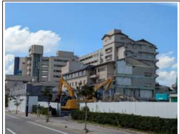
取り壊し作業が進む和倉温泉の大規模旅館の建物
